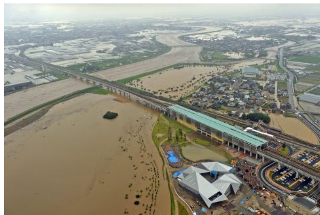
昨年7月の九州北部豪雨で決壊した矢部川 - 冠水した九州新幹線の筑後船小屋駅付近の状況 - (NHK2012)
