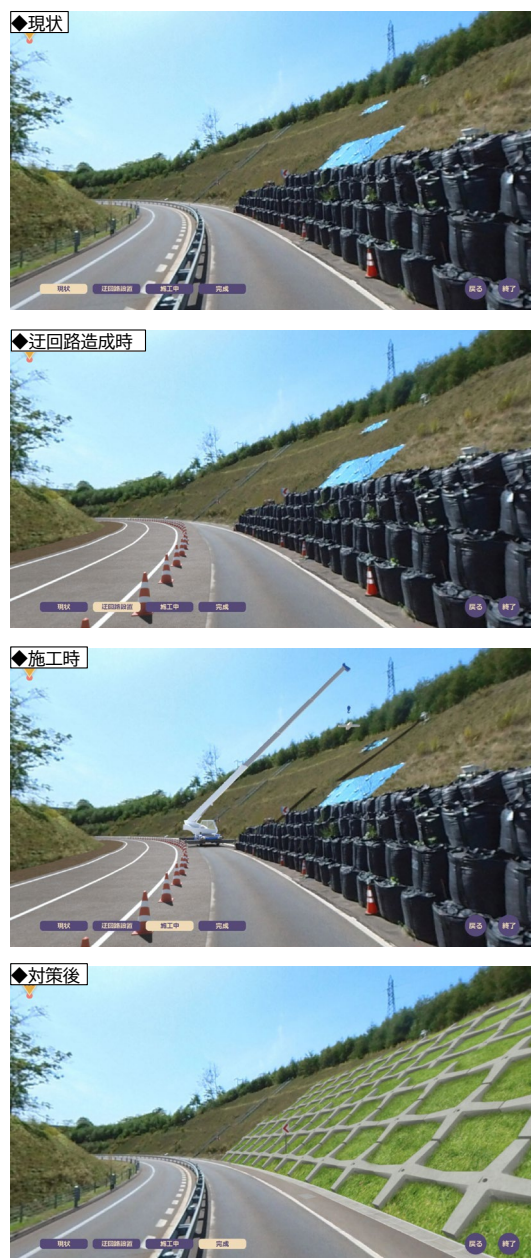
第 5 図 360° 画像+3 次元データによる施工ステップ図
